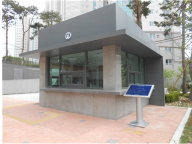
〈그림 4-42〉 경비실 점자블록, 점자안내판 설치 사례
